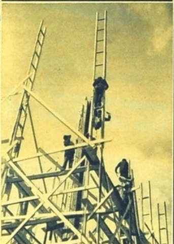
A gerendák emelkednek. * The hoisting of beams. * Les planches s'élèvent. * S'innalzano le travi...
