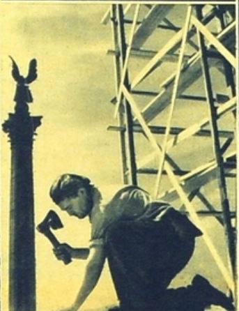
Álványozás. * The scaffolding. * Echafaudage. * L'armatura di legno in costruzione.
