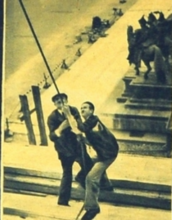
Épülőfőben. * The High Altar in construction. * L'autel de la solennité en construction. * L'altare solenne in costruzione.
